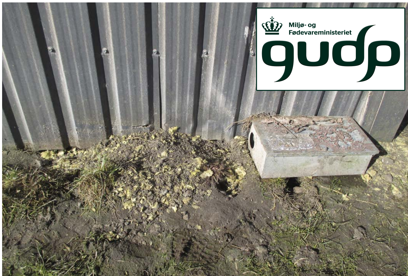
Rottehuller ved bygning og rottegift kasse. Rotterne har gnavet isoleringen ud af væggen. Foto: Kristian Knage-Drangsfeldt, SEGES, Økologi.
